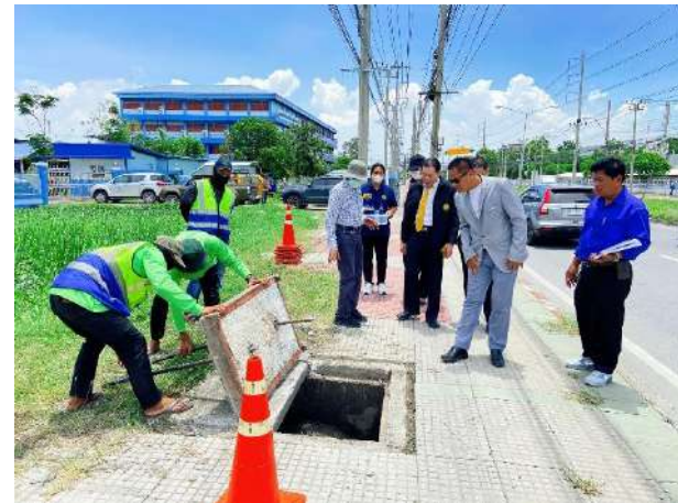
ภาพ : การลงพื้นที่สาย สป.๒๐๐๑ แยกทางหลวงหมายเลข ๓๔ - บ้านลาดกระบัง อำเภอบางพลี, อำเภอบางเสาธง จังหวัดสมุทรปราการ ท่อลอดเหลี่ยม ขนาด ๑.๐๐ เมตร
